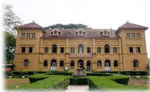
ศาลากลางจังหวัดนครพนม (สร้างเมื่อ พ.ศ. ๒๔๕๘ - ๒๔๖๒)
