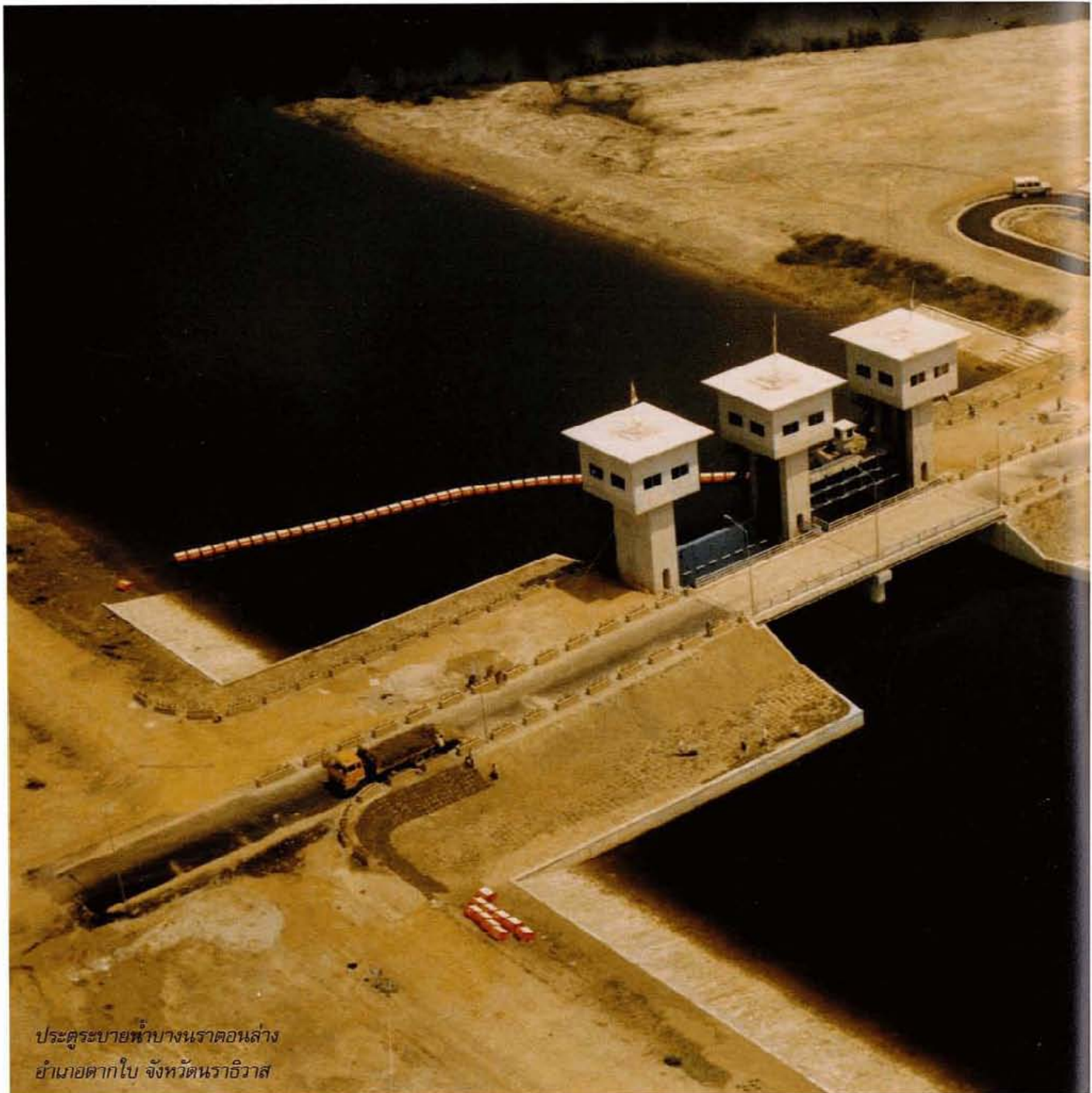
ประตูระบายน้ำบางนราตอนบน อำเภอเมืองนราธิวาส จังหวัดนราธิวาส
