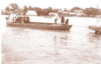
การวางสายเคเบิลโทรเลข
