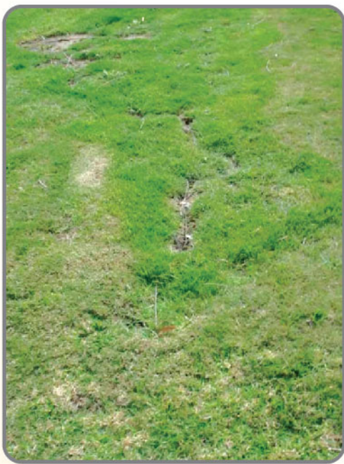
ตัวอย่างแนวรอยแตกบนตลิ่งในแนวขนานกับตลิ่งที่แสดงว่า ตลิ่งอาจจะพังทลายตามแนวรอยแตกนี้ได้ (ที่มา: Study into River Bank Collapsing- Lower River Murray Sinclair Knight Merz, 2010.)
