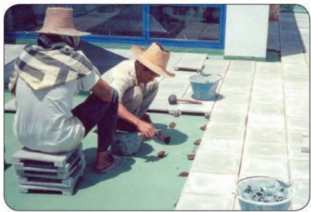
(ภาพขวา) การปูแผ่น Solar Slab บนฝ้าคาน้ำ
